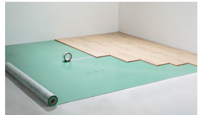
Verlegung eines MMF-Belags auf mineralischer Unterlage Fotos rechte Spalte: Windmüller
