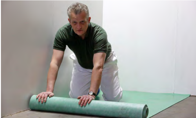
Ausrollen der Verlegeunterlage für SPC Beläge
