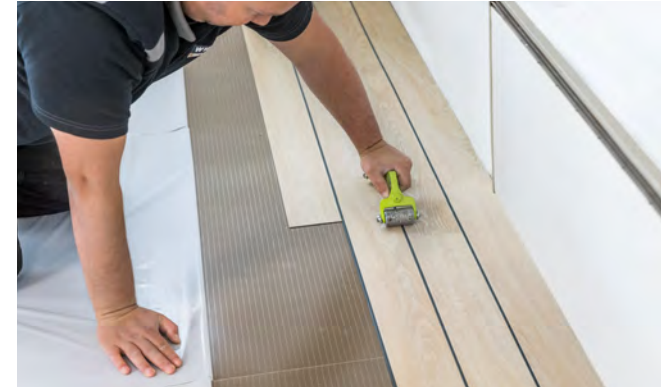
Dry Back Verlegung auf haftender, mineralischer Unterlage
