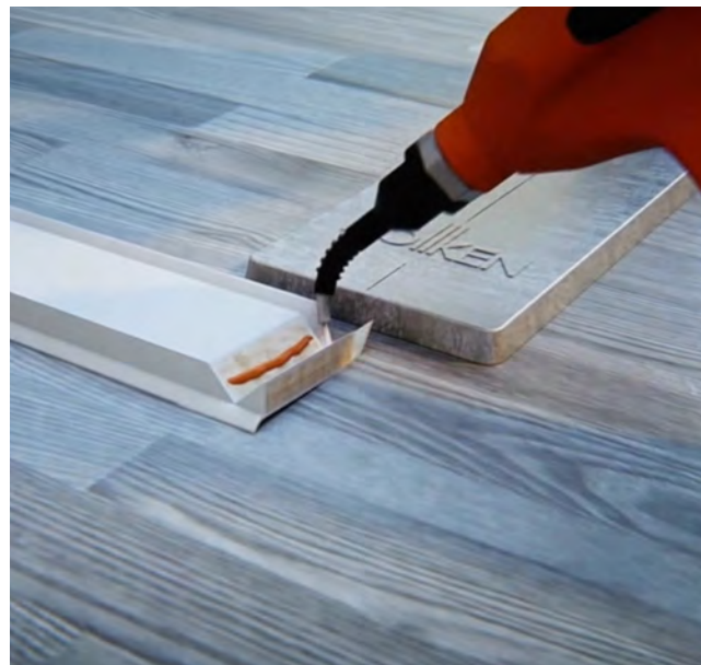
Schmelzkleber auftragen
