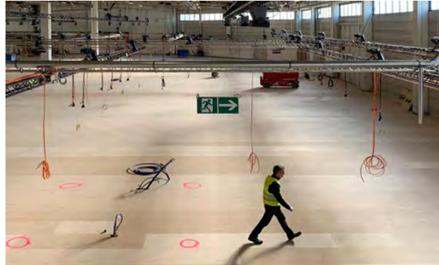
Das Unterbodensystem liegt
