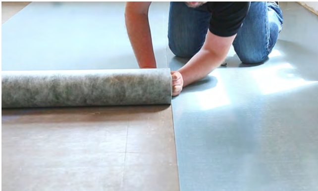
Sanierungsunterlage für LVT Dryback Verlegung auf PVC-Alt-Belag
