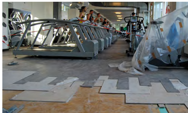
Vorteil: Trotz Umbau läuft der Betrieb weiter Fotos mittlere Spalte: Unifloor
