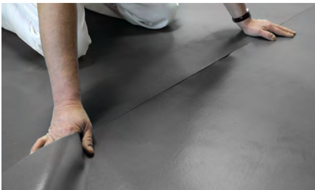
Verlegeunterlage auf Stoß anlegen Fotos linke Spalte: Prinz
