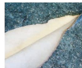
Delaminierung nach Überbeanspruchung durch Stuhlrollen
