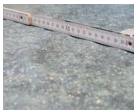
Zerstörung durch harte Rollen
