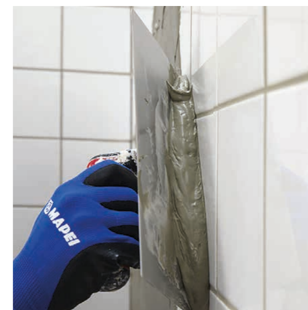
Geeignete Wandspachtelmassen können auch ohne Grundierung verarbeitet werden. Foto: Mapei
