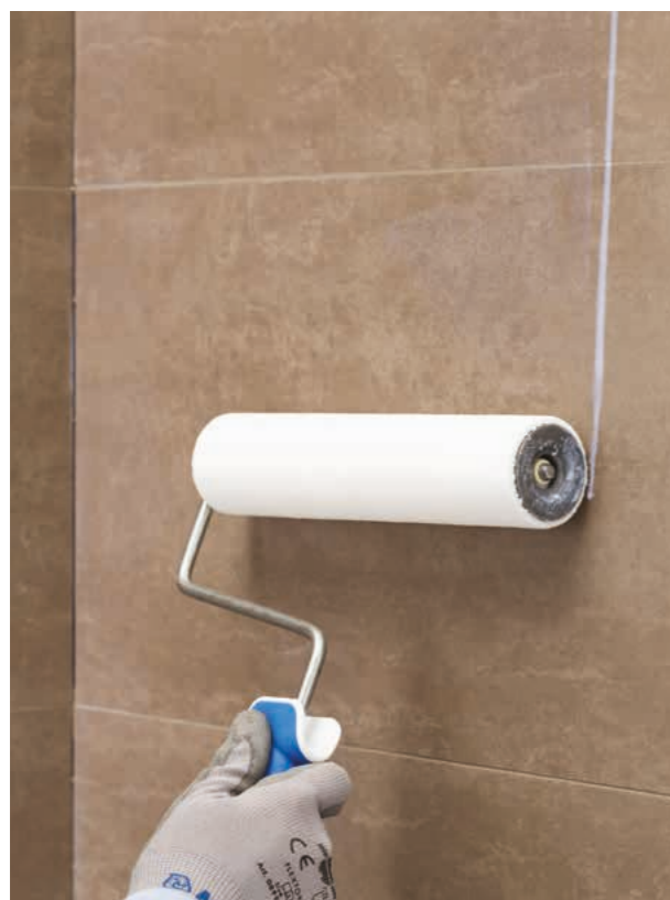
Empfohlen wird die nachträgliche Versiegelung der verlegten Beläge. Foto: Mapei
